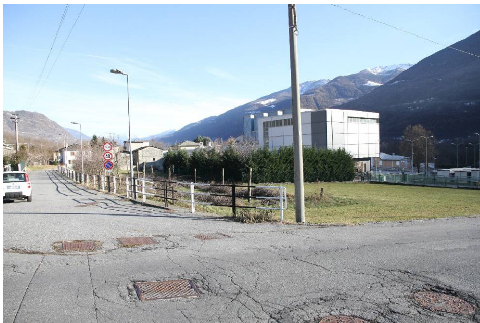
AREA CON PREVISIONE PARCHEGGIO RESIDENZIALE E AREA A VERDE VIA SPINEDI INCROCIO VIA PRADETTI (RIF. PDS – 25 PARCH. – 7 VPA)
