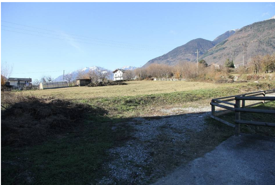
AREA PARCO GIOCHI (INTERVENTO IN CORSO) (RIF. PDS – 6 VPA)
